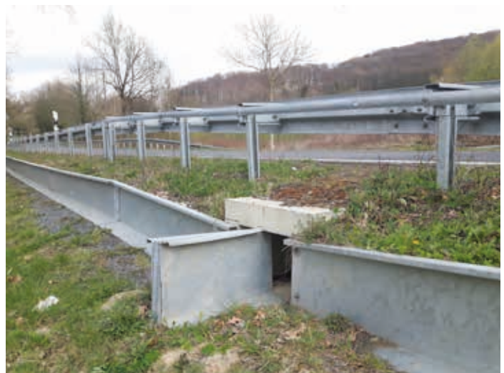
Diese fest installierte Leitplanke leitet Amphibien zu einem Tunnel und sicher unter der Straße hindurch.
