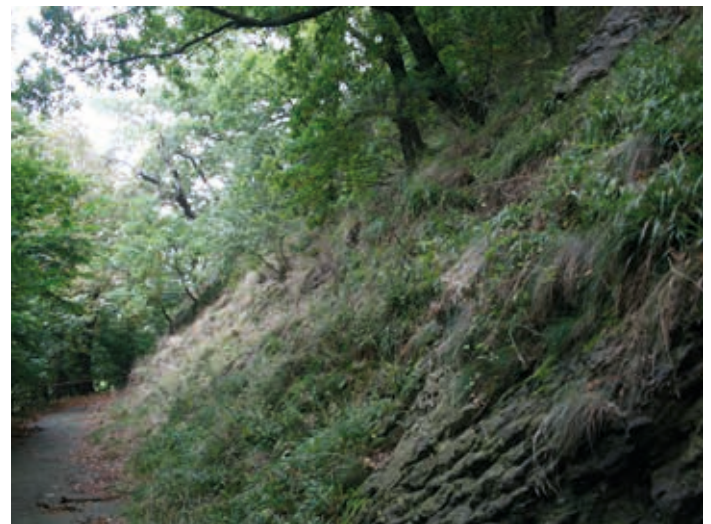
... Erhalt besonders seltener Felslebensräume im FFH-Gebiet Siebengebirge, auch unter Aufgabe des oberen Eselsweges?
